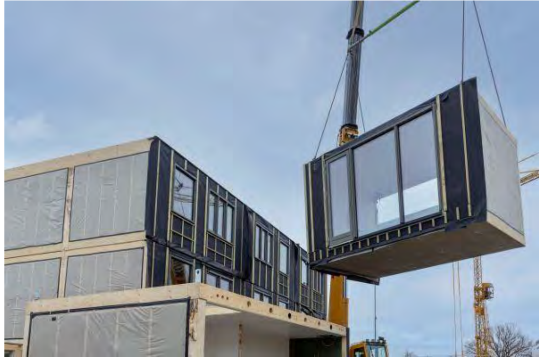
Houtbouw modules, Hengelo
