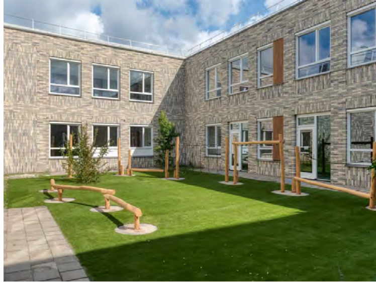
Hergebruik kozijnen, Avignonlaan Eindhoven
