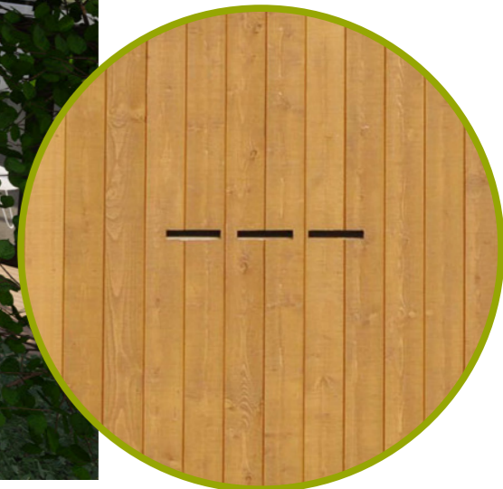
Nestkasten dakrand Voor vleermuizen.
