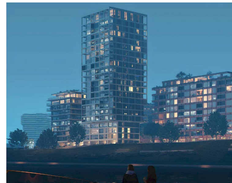
De architectuur van het distrikt bestaat uit een lijnenspel bovenop een solide plint. Koschuch - Waalkwartier Toren
