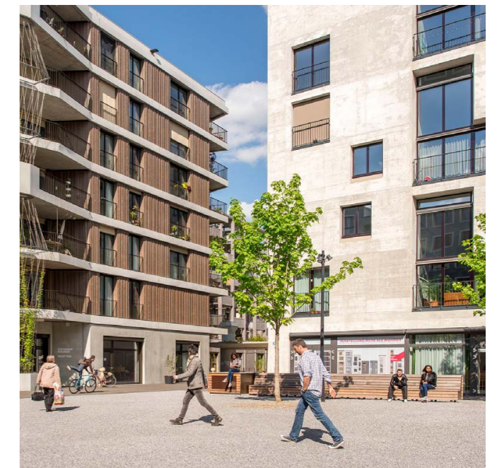
Aan de randen van de pleinen is ruimte voor activiteiten. Plinten met winkels, horeca, maakbedrijven en kantoren zijn goed zichtbaar. Op de hogere verdiepingen bevinden zich woningen en kantoren. Mehr als Wohnen, Zürich
