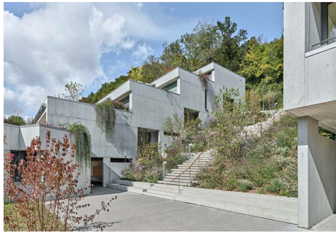
Voorbeeld - De bebouwing kan meebewegen met de terp. Diethelm & Spillman - Sommerhalde Terrace House
