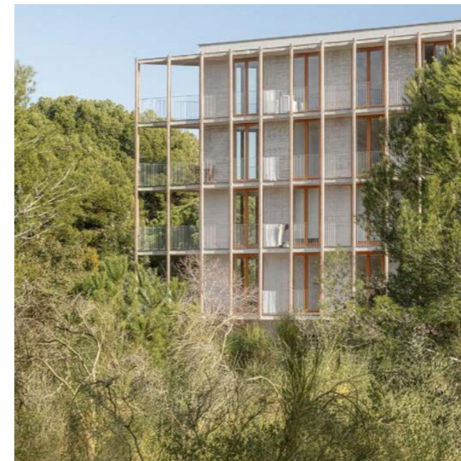
De bebouwing vormt een neutrale begrenzing van het weelderige park. Harquitectes - Social housing 1737
