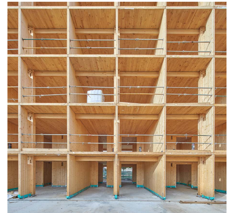
Seriematige houten draagstructuur levert efficiëntie en snelheid op de bouwplaats op. Binnen het stramien zijn zeer diverse woningtypes mogelijk.
